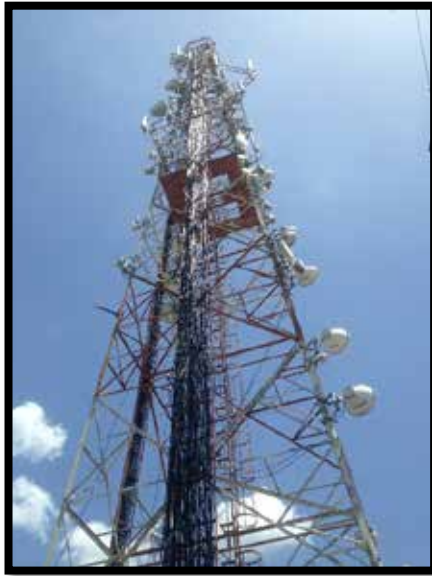
Figura 2: Torre de Telecomunicaciones Fuente: Bou Mansour, Figueredo (2019)
