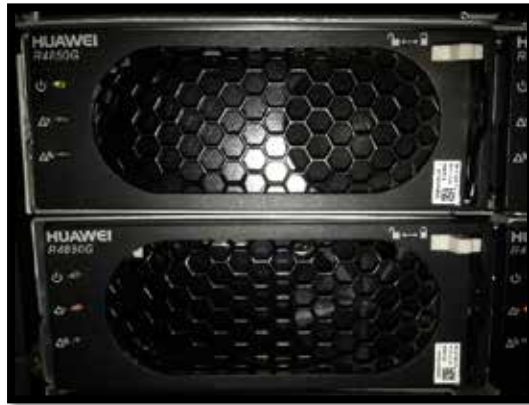
Figura 25: Rectificadores HUAWEI R4850G 50A Fuente: Bou Mansour, Figueredo (2019)
