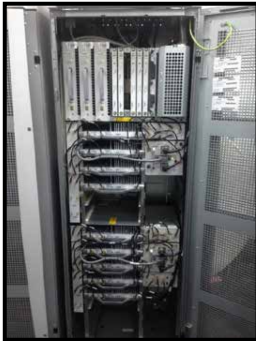
Figura 19: BTS NOKIA 1900 MHZ Fuente: Bou Mansour, Figueredo (2019)
