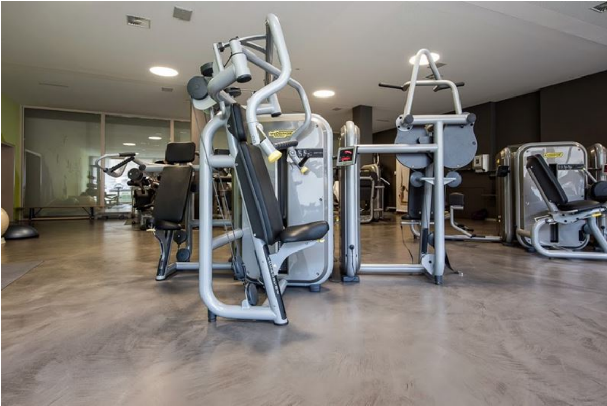
Figura 49. Cemento pulido en gimnasio. (2017)
