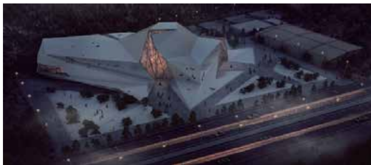
Figura 3. Rock Gym. Fuente: http://www.plataformaarquitectura.cl/cl/02-334350/new-wave-architecture-disena-rock-gym-para-polur/52e1b30be8e44e081d00003c .(2014).
