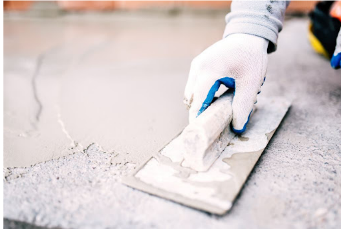
Figura 25. Acabado superficial en hormigón.
