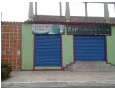
Figura 32: Laboratorios, Vía de Servicio de la Urb. La Esmeralda
