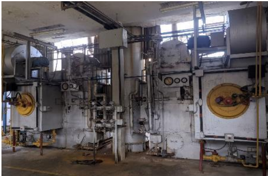
Figura 2: Ilustración de las calderas 1 y 2 (20.000 lb/h c/u)
