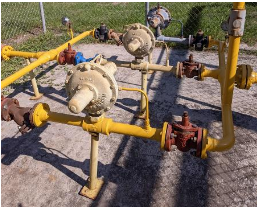
Figura 16: Distribución de entrada de gas natural a las calderas Fuente: Rosales, D. (2023)
