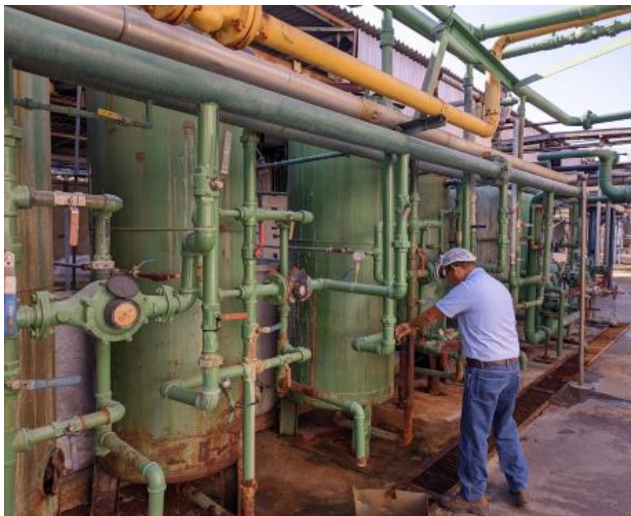
Figura 17: Zona de tratamiento de agua para las calderas (suavización) Fuente: Rosales, D. (2023)
