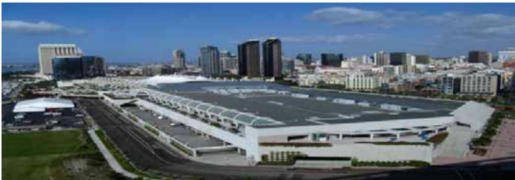
Figura 4. Vista aérea del Centro de Convenciones de San Diego
