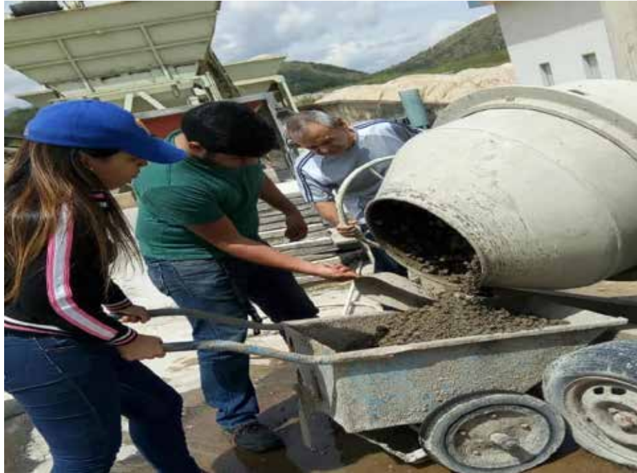
.Preparación de la mezcla para la toma de probetas Fuente. Los autores (2018)
