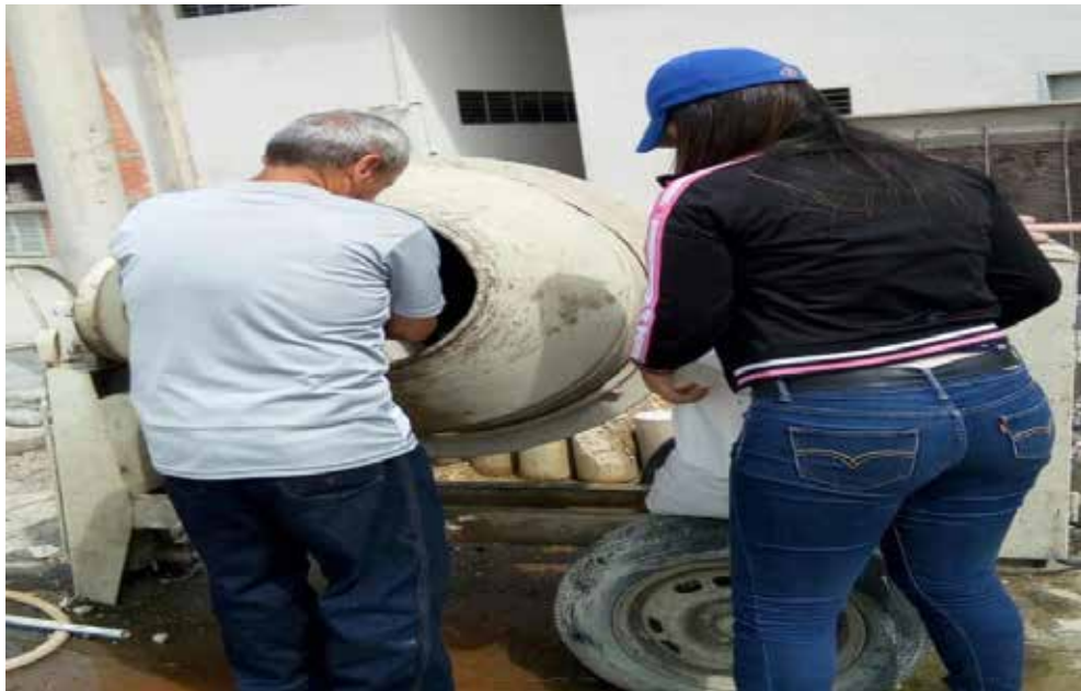
Figura 11. Preparación de la mezcla para la toma de probetas Fuente. Los autores (2018)
