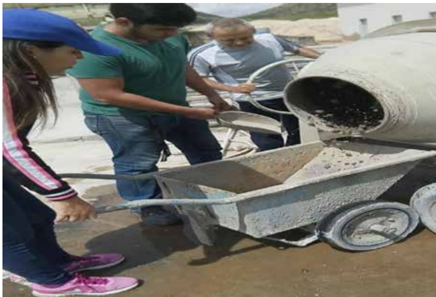
Preparación de la mezcla para la toma de probetas Fuente. Los autores (2018)
