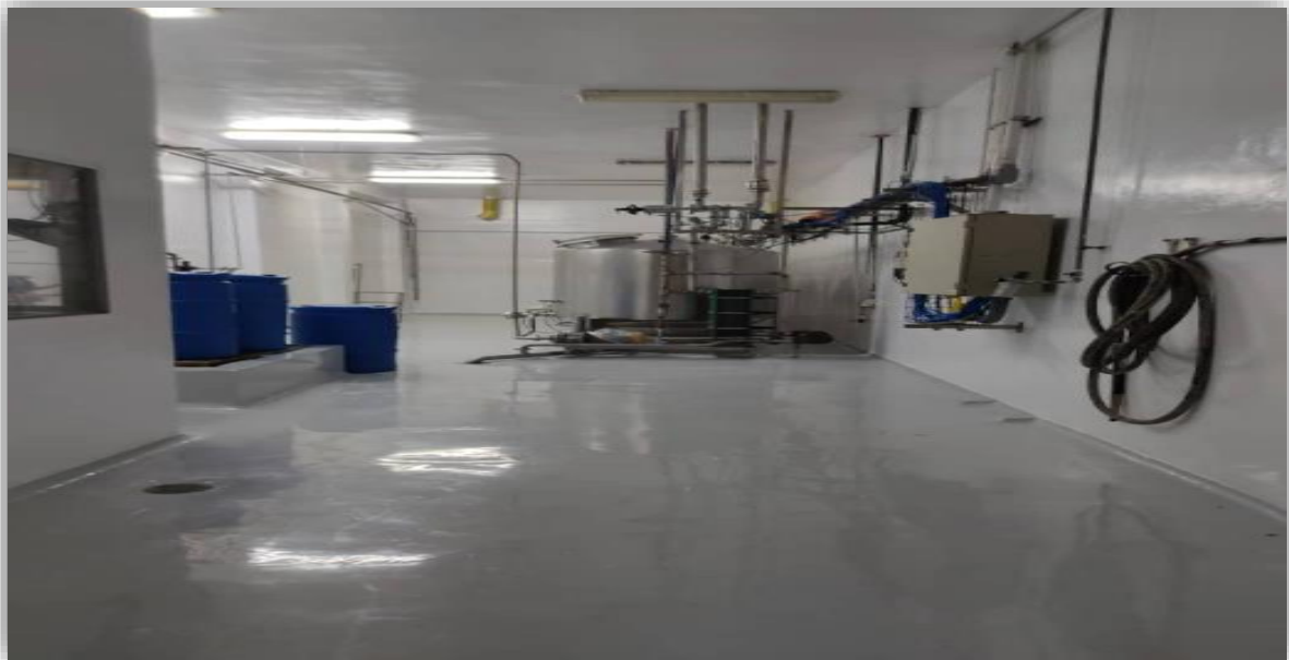
Figura n°17. Ilustración de la Sala CIP.
