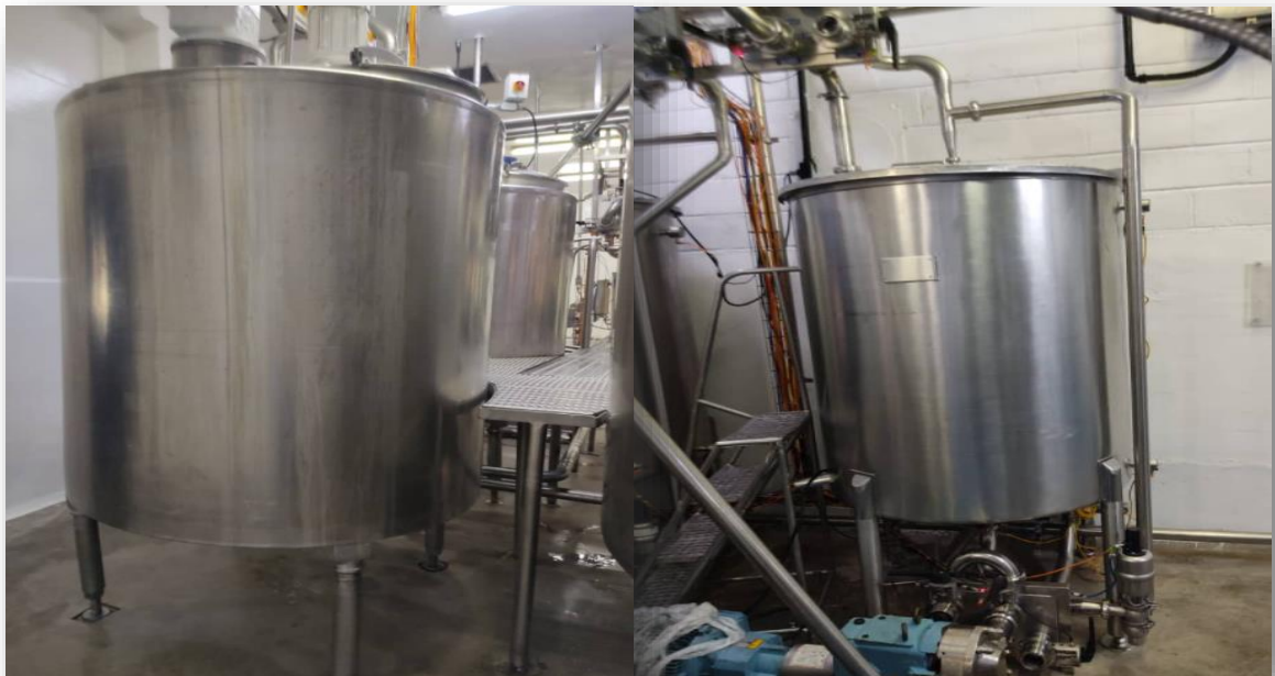
Figura n°23. Ilustración de tanques de llenado higienizados por el CIP (Tanque de llenado)
