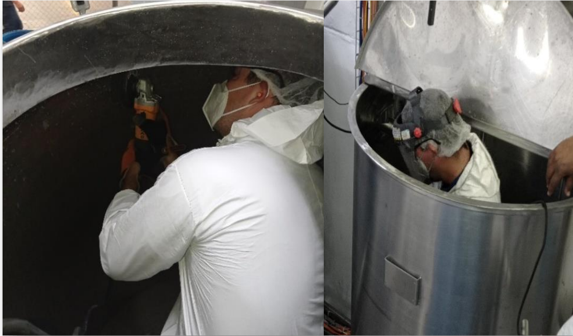
Figura n°7. Ilustración de Pulidoras mecánicas a los que son sometidos los tanques de la línea de Mayonesa y llenado.
