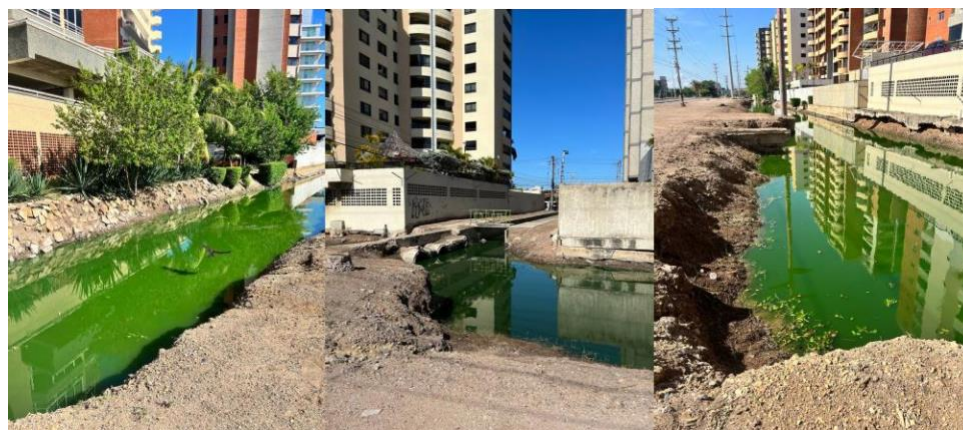
Figura 18. Canales donde los edificios desembocan sus aguas residuales.
