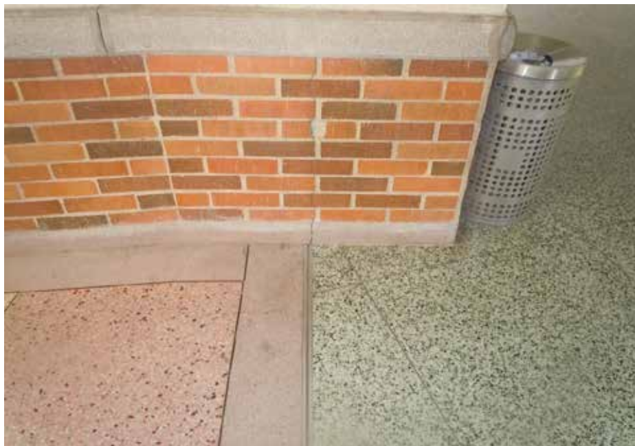
Junta sismica entre modulo 3 y modulo 2.
