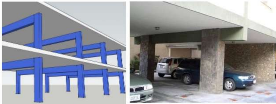
Figura 8 Ausencia de vigas altas
