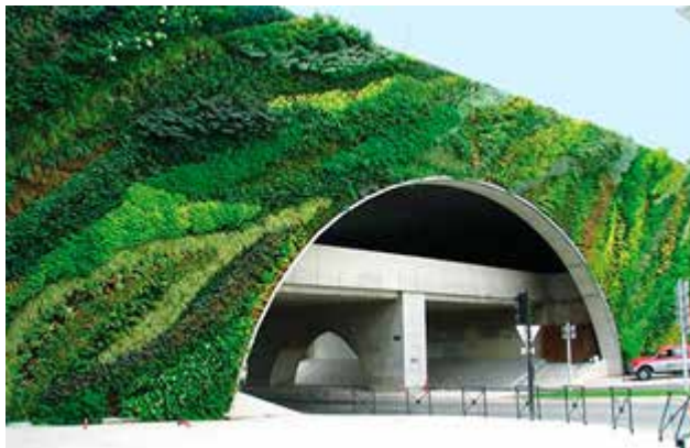
Figura N°43 Puente en Francia con jardín vertical
