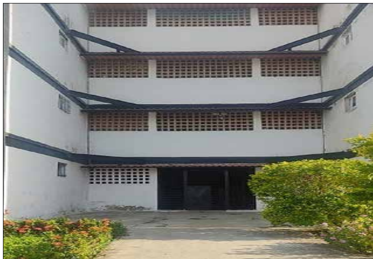
Figura 13: Vista de Edificaciones existente en Ciudad Plaza III, Mpio. Valencia.
