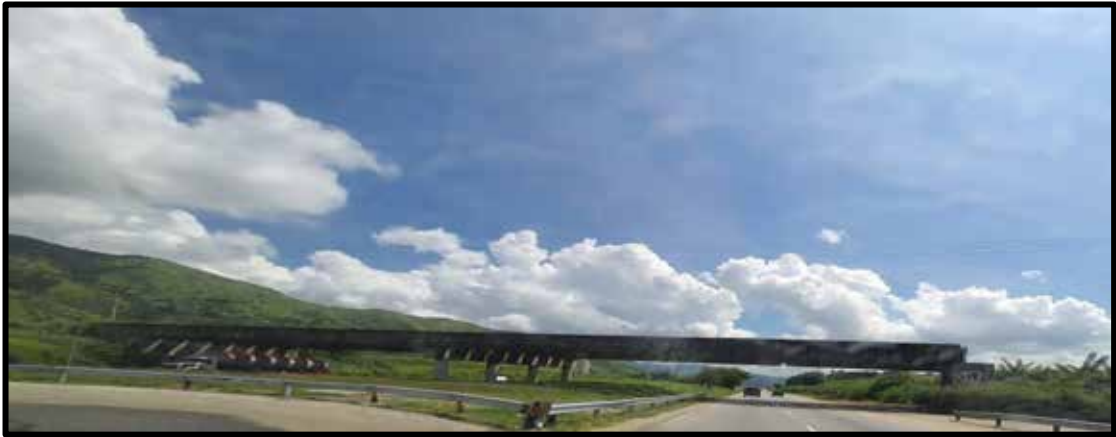
Figura 5. Estructura de la obra incluida del puente olvidado. Fuente: García, J. (2020)
