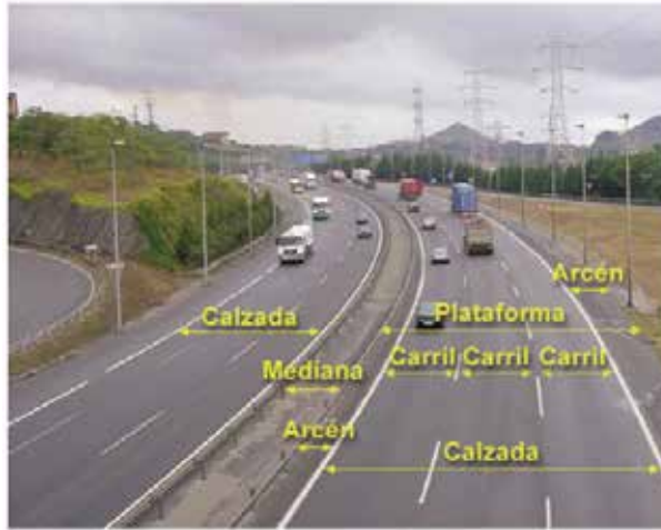
Figura 2: Dibujo de Partes que Componen una Vía Fuente Automager. Tema 3.
