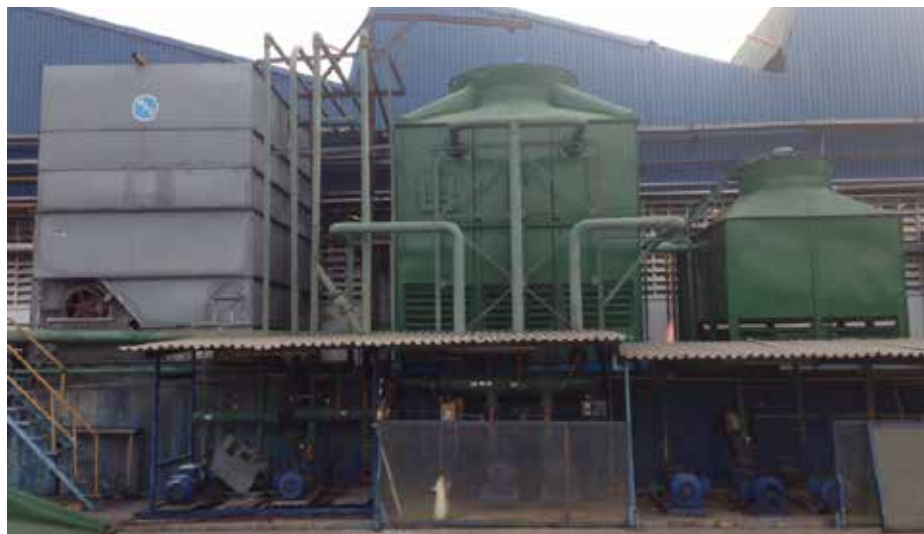
Figura 6. Torres de enfriamiento de Alcave planta Conal.
