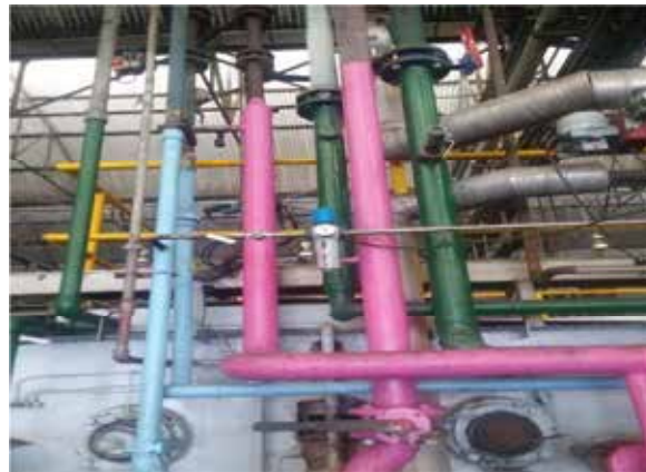
Cada tubo de color indica Rosado: soda cáustica Verde oscuro: Agua Azul claro vapor
