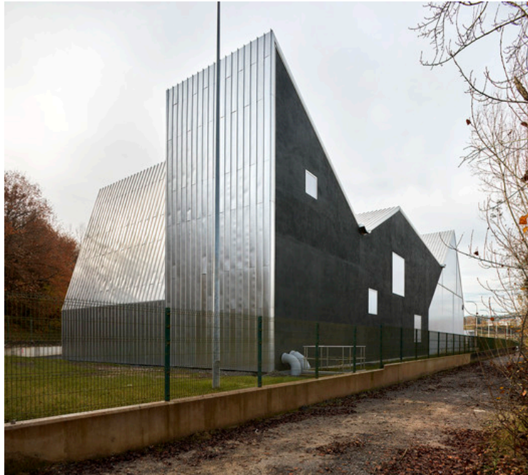
Figura 4 Edificio de Planta de Tratamiento San Claudio. Fuente: https://www.plataformaarquitectura.cl/cl/872302/edar-san-claudio-padilla-nicas-arquitectos?ad_source=search&ad_medium=search_result_all
