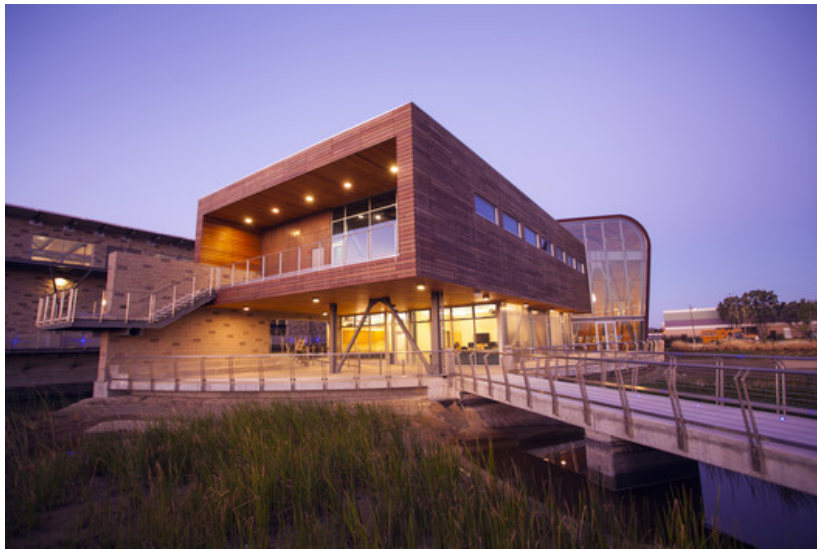
Figura 1 Edificio de Instalación de Purificación de Agua Avanzada. Fuente:
