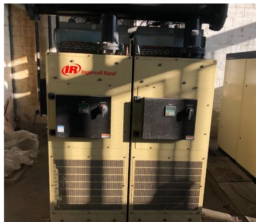
Figura 7. secador de refrigeración
