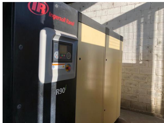
Figura 5. Compresor de tornillo.
