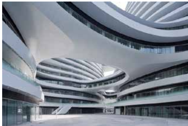
Figura 3: Galaxy SOHO. Vista desde patio central. Fuente: https://www.plataformaarquitectura.cl/cl/02-202925/galaxy-soho-zaha-hadid-architects
