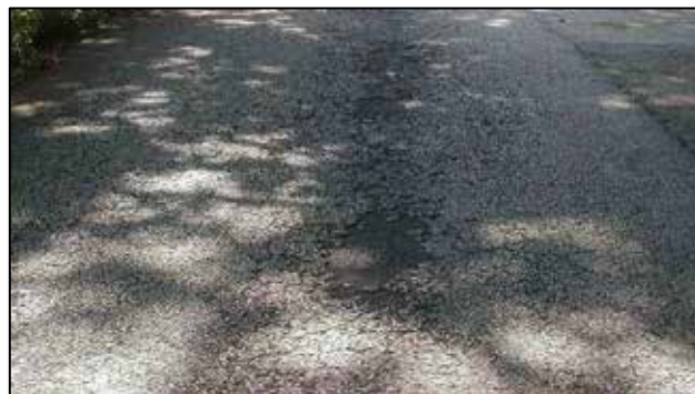
Figura 64: Pérdida del agregado en la calle Cumaca.
