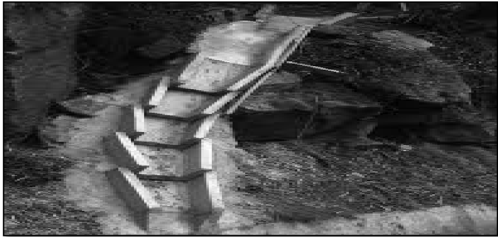
Figura 27: Torreteras con elementos Prefabricados
