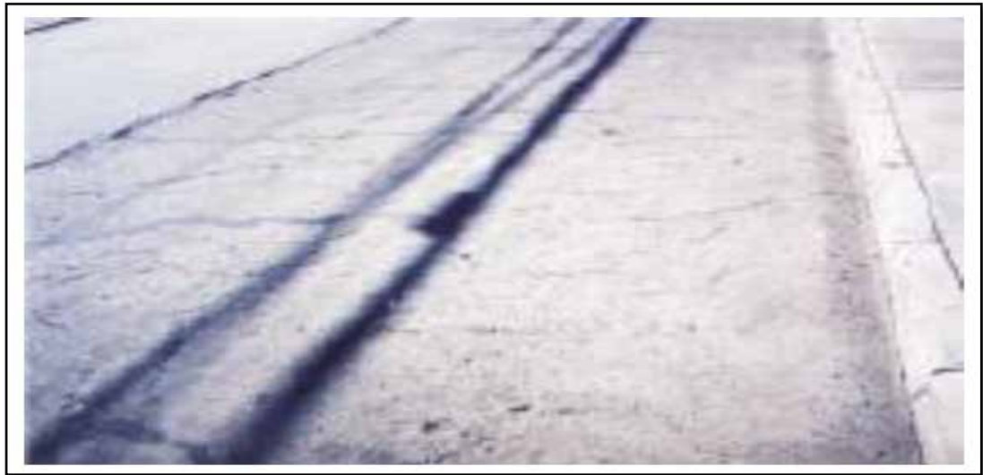
Figura 15. Deterioro superficial del pavimento rígido
