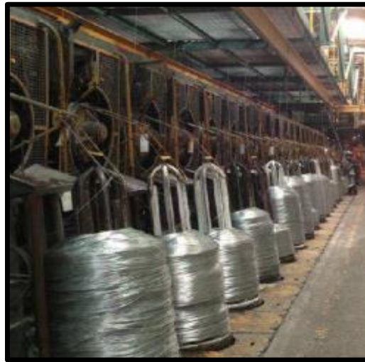
Figura 5. Banco enrollador de la línea de galvanizado dos (2) en la empresa Vicson, S. A.
