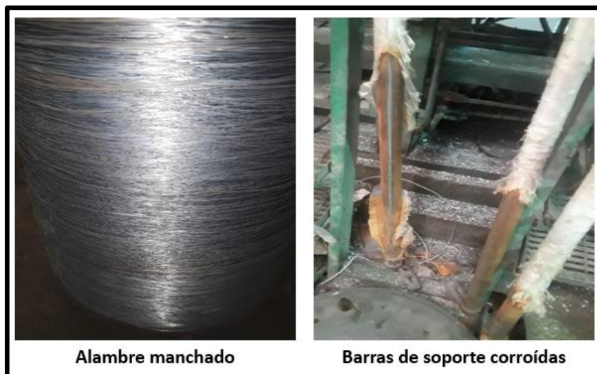
Figura 24. Situación actual por barras de soporte corroídas.
