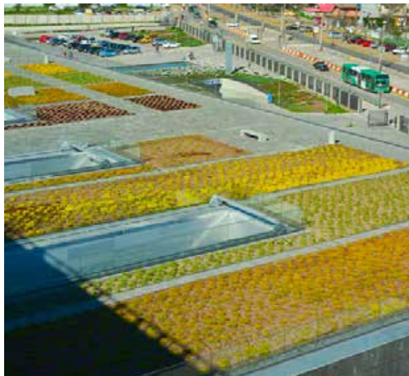
Figura 72. Cubierta vegetal en techo de centro cultural. Fuente: http://www.Plataformaarquitectura.cl/catalog/cl/products/1991/cubiertas-vegetales-tecpro (2017)
