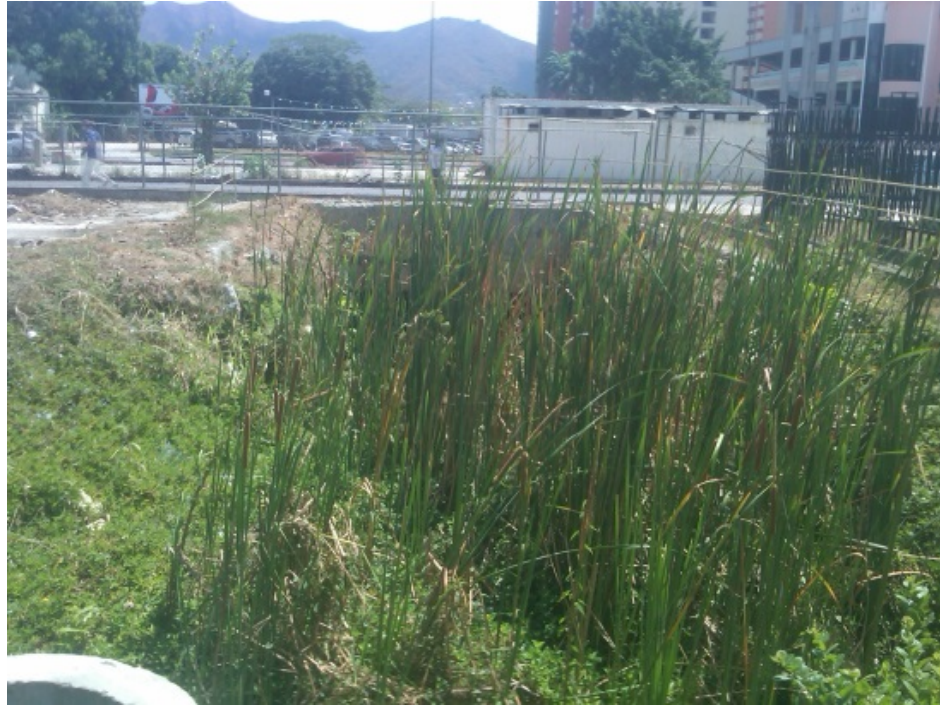
Figura 29. Construcción de Salida de Metro Valencia. (2017)
