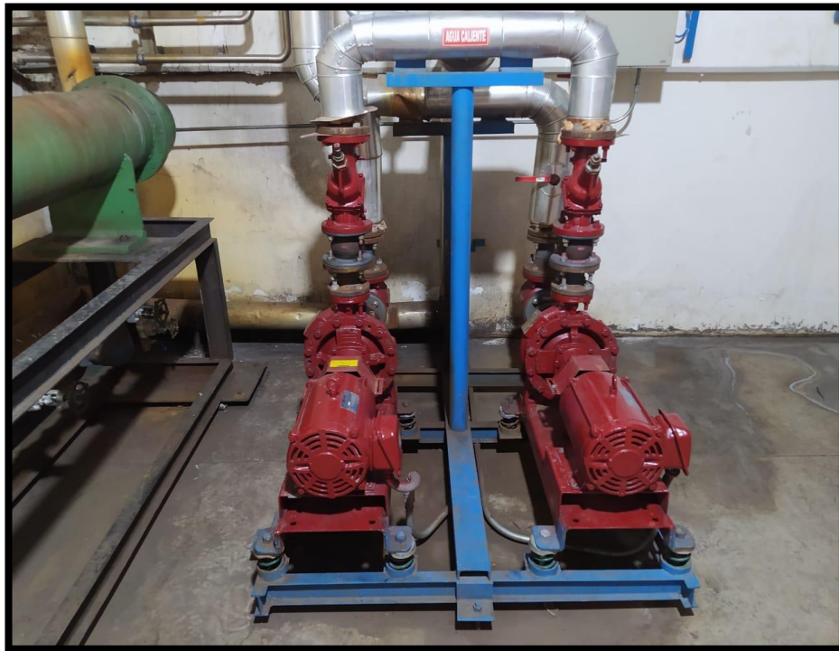
Figura 15. Bombas centrífugas Armstrong modelo 4030 Fuente: Barrios y Bolívar (2023)
