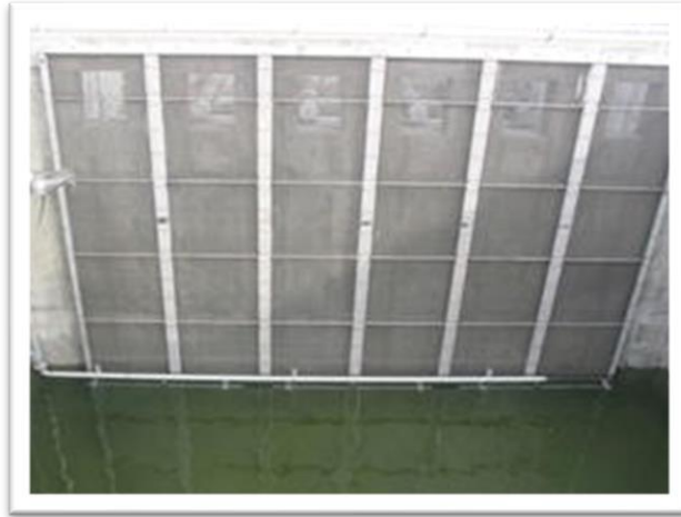
Figura 31. Filtro vertical para MBBR anaeróbico.
