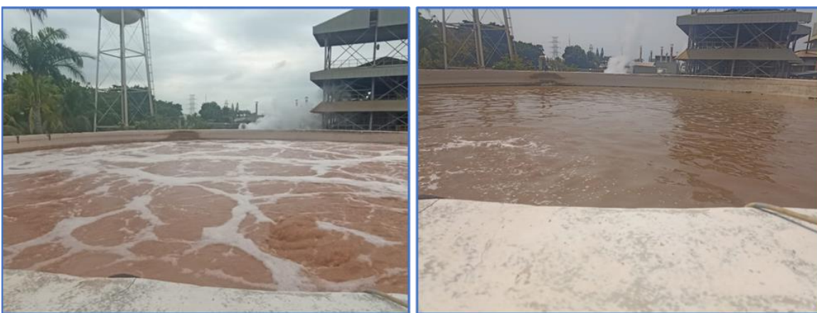
Figura 3. Ejemplo de acción para contener lodos en el reactor biológico.
