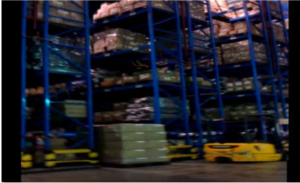
Figura 8. Zonas colapsadas dentro del almacén
