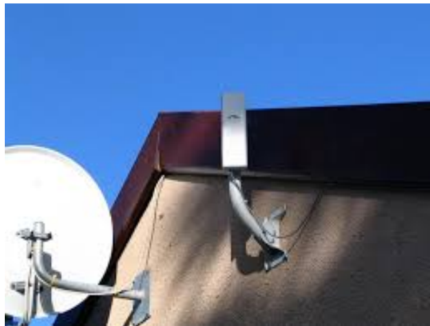
Figura 39: Ejemplo de una BS del cliente con montura de pared.
