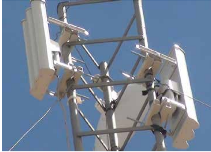
Figura 37: Ejemplo de una BTS con antenas sectoriales. Fuente: es.tinypic.com/r/2qa4car/9 (2017)
