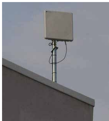
Figura 40: Ejemplo de una BS del cliente con montura sobre techo.
