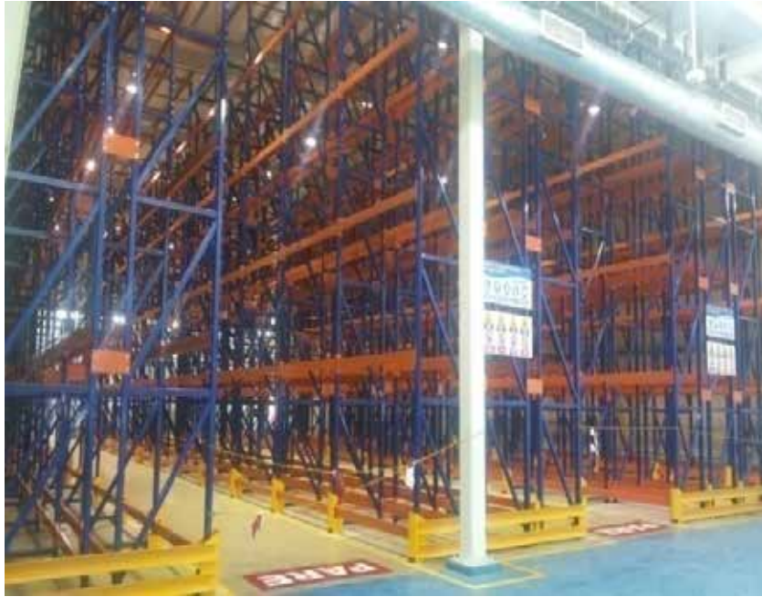
Figura 11. Rack para el almacén de productos no refrigerados. Fuente: Rangel y Vegas (2019)
