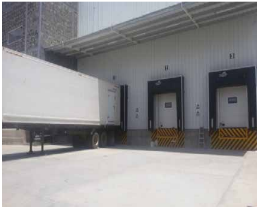
Figura 12. Área carga y descarga de productos refrigerados y congelados. Fuente: Rangel y Vegas (2019)
