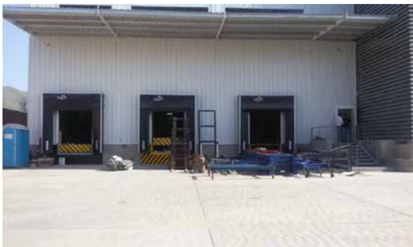
Figura 10. Área de carga y descarga de productos no refrigerados.
