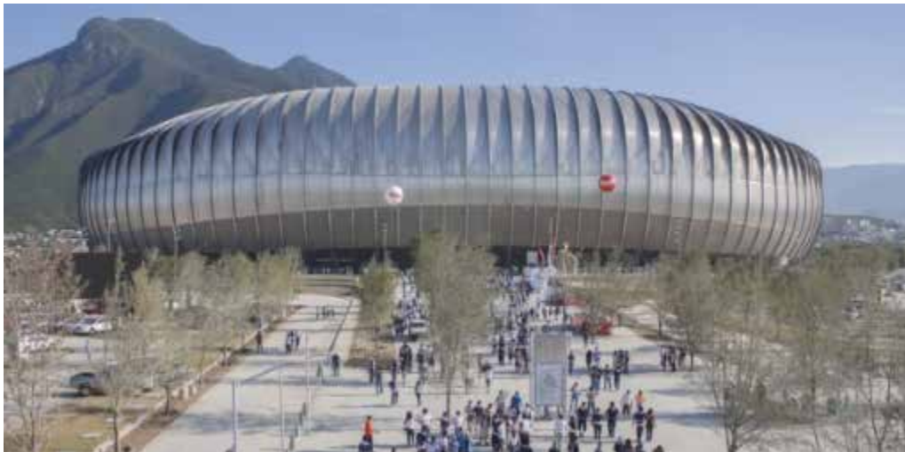
Figura 1: Vista de la Fachada del Estadio BBVA Bancomer
