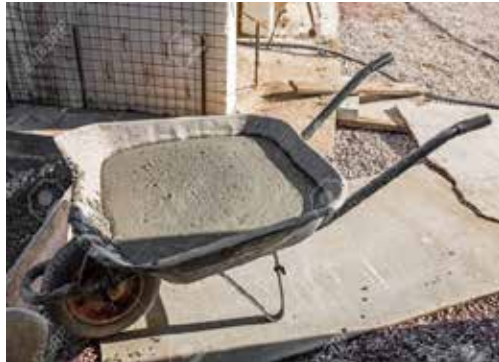
Figura 7: Mezcla de concreto.
