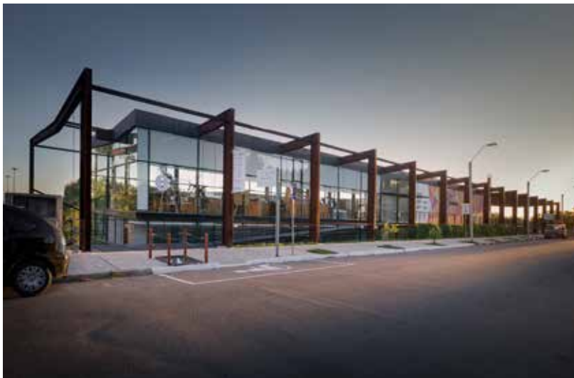
Figura 10. Fachada Principal del BIT. Fuente: http://arqa.com/arquitectura/centro-de-bienvenida-interpretacion-y-turismo-del-uruguay.html (2015)
