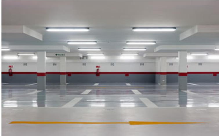
Figura 62: Vista del acabado final en pisos de estacionamientos. Fuente: http://www.pisosepoxicosindustriales.mx/aplicacion.html (2008)
