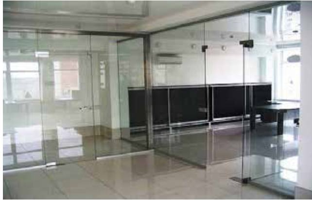
Figura 57: Aplicación de paneles de vidrio y perfiles de aluminio en locales comerciales y oficinas. Fuente: http://www.archiexpo.es/prod/comtrust-architectural-mesh-co-ltd/product-105639_1516327.html#product-item_1516324 (2016)
