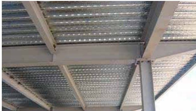
Figura 61: Vista del acabado de láminas de losacero . Fuente: http://www.centrolit.com.ve/Articulos.php?articulo_no=177& (2005)
