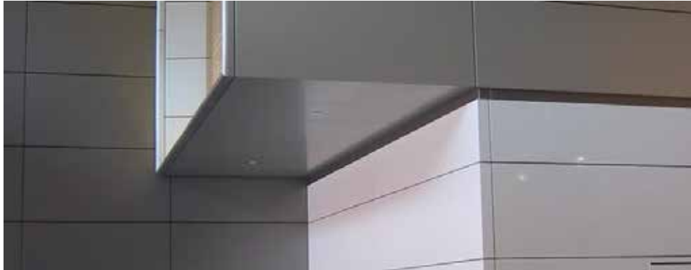
Figura 56: Aplicación de Panel Alupremium® Plateado en fachada. Fuente: http://www.aluminiocompuesto.com/images/bconstruction_main.jpg (2016)
