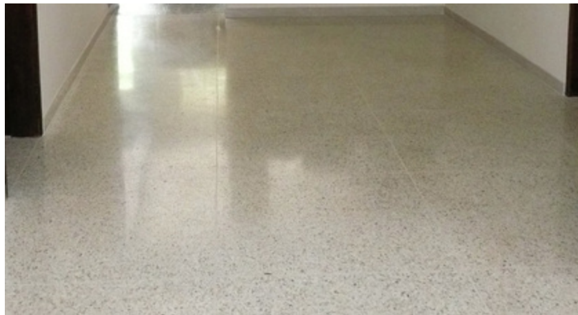
Figura 63: Vista del acabado final de granito emplomado en pisos de áreas de Servicio. Fuente: http://lunamarmol.weebly.com/mantenimiento.html (2016)
