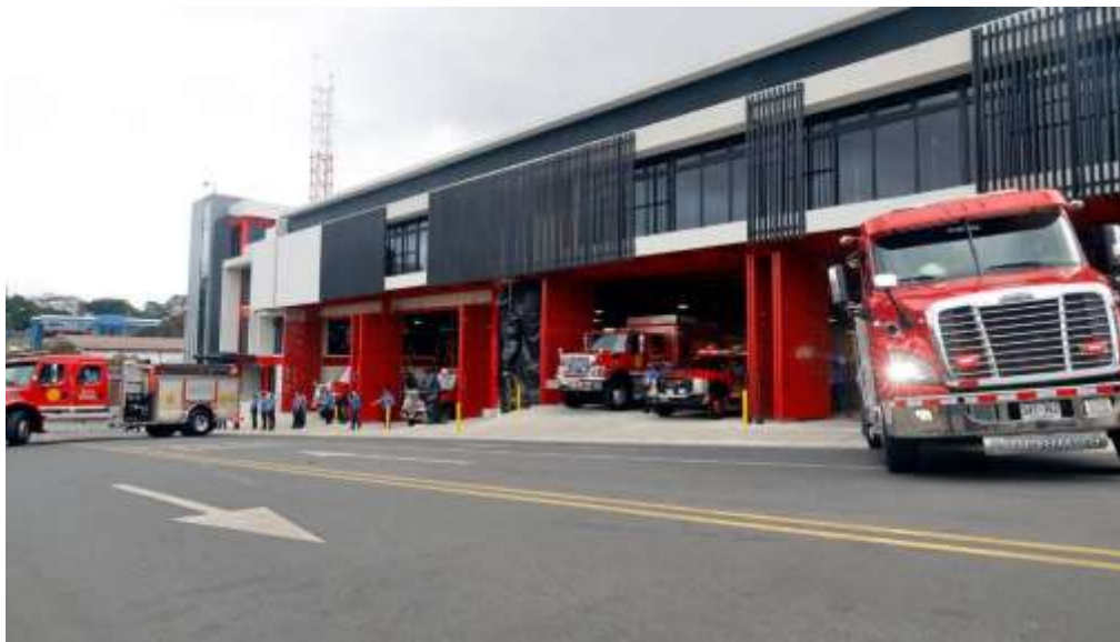
Figura 3. Vista Fachada Estación de Bomberos, San José, Costa Rica. (Fuente: https://www.monumental.co.cr/2020/12/06/bomberos-inaugura-dos-nuevas-estaciones-metropolitanas-de-alta-tecnologia/ ).
