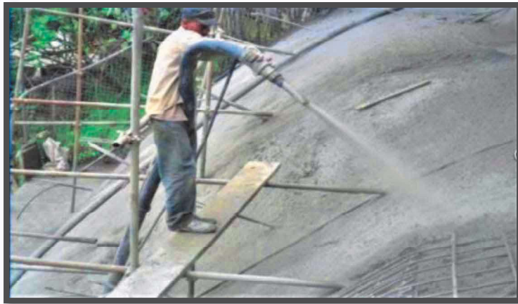
Figura. -23: Proyección del concreto en pantalla
