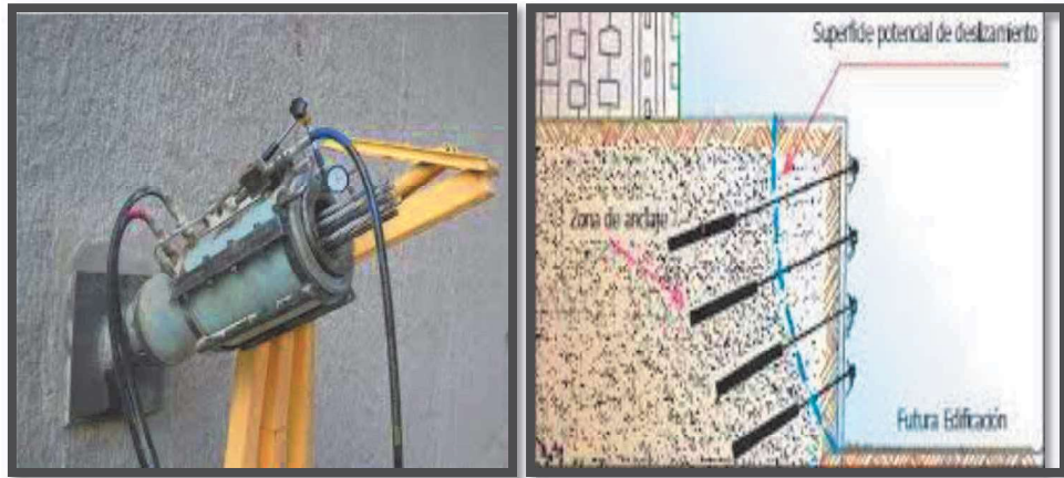
Figura. -25: Instalación de anclajes
