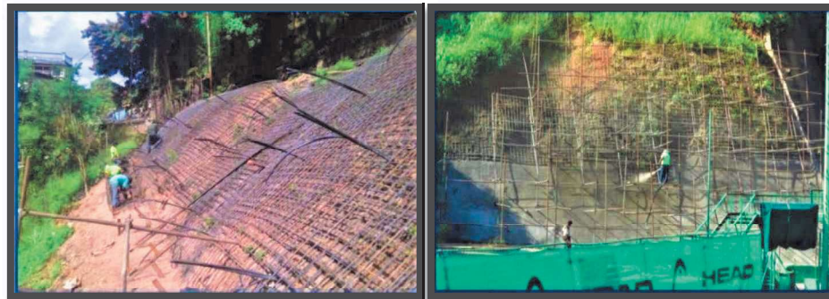
Figura. -22: Armado de pantalla atirantada
