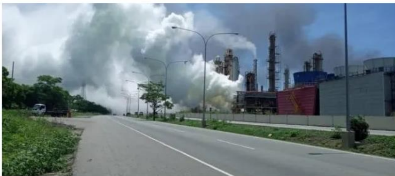
Figura 1. Fuga de gases en la refinería El Palito.
