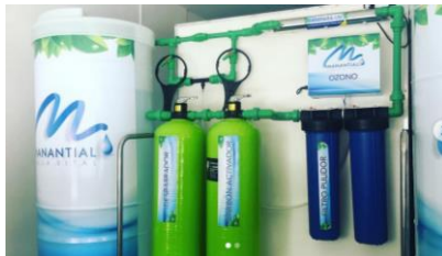
Figura 5: Sistema de filtrado y purificación de agua.
