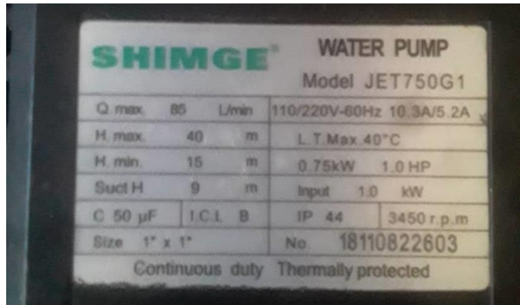
Figura 28: Especificaciones de la bomba disponible en la planta
