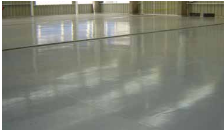
Cemento Epoxico pintado.
