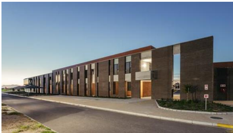
Figura 3: Vista Externa “Planta de residuo de aguas, 2019”
