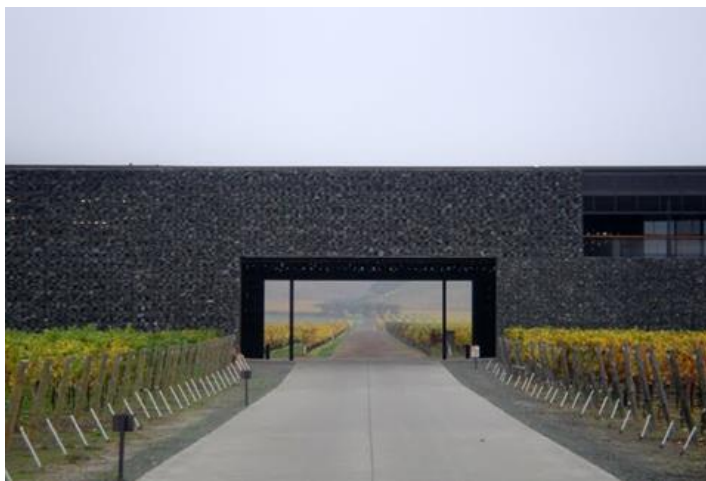
Figura 4: Fachada frontal de Dominus Winery “Planta de residuo de aguas, 1998”
