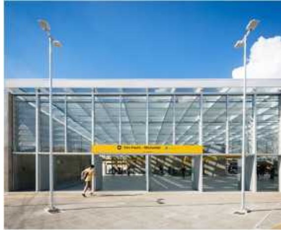
Figura 3. Estación de Metro São Paulo - Morumbi. Fuente: Plataforma Arquitectura (2018)
