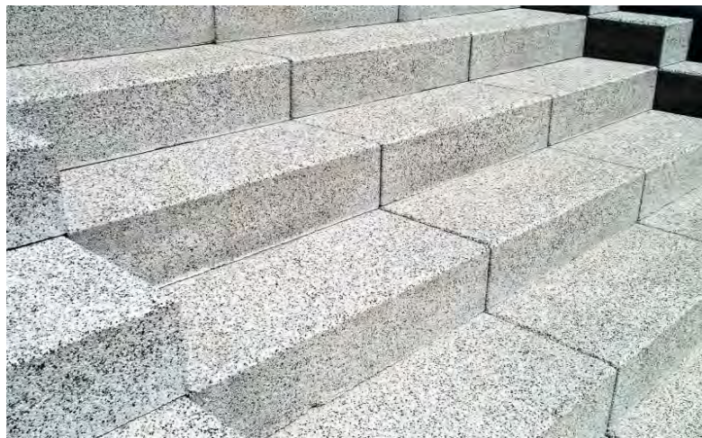
Figura 19. Ejemplo de piso de granito. Fuente:
