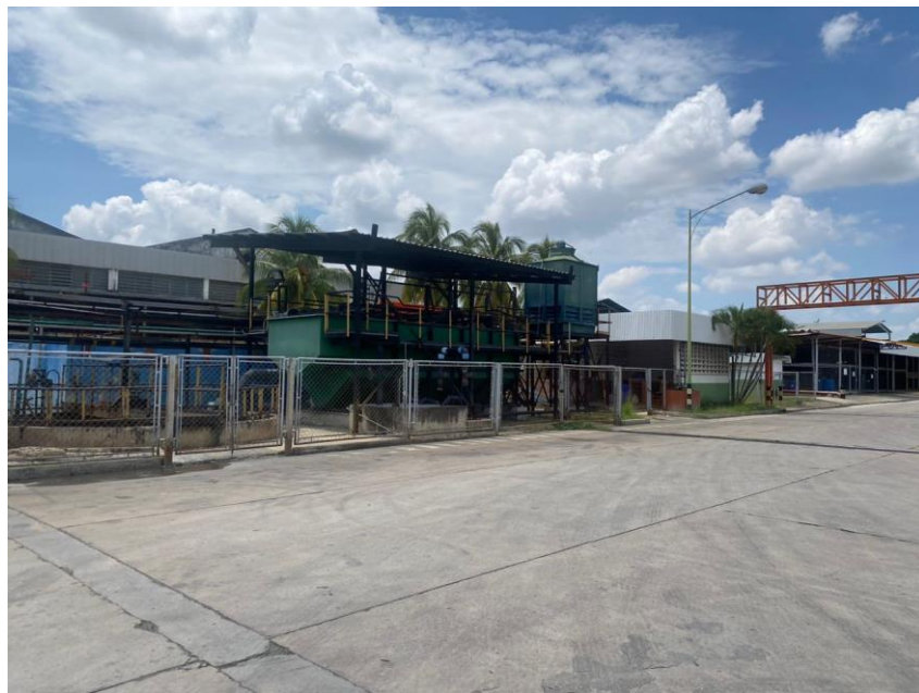
Anexo 02: Fachada Principal de PTAR
