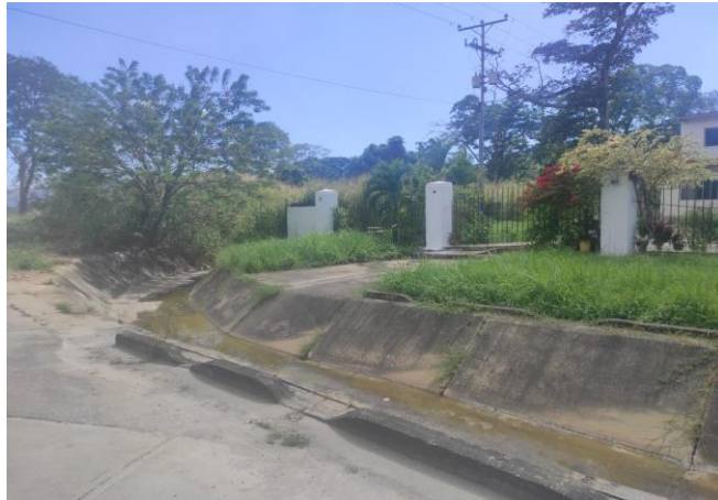
Figura 14. Tramo final canal 1 Fuente: Haffar (2023)
