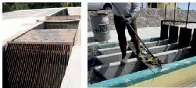
Figura 1. Rejas y rejillas de limpieza manual y su operación. Comisión Nacional del Agua, México. (2016).
