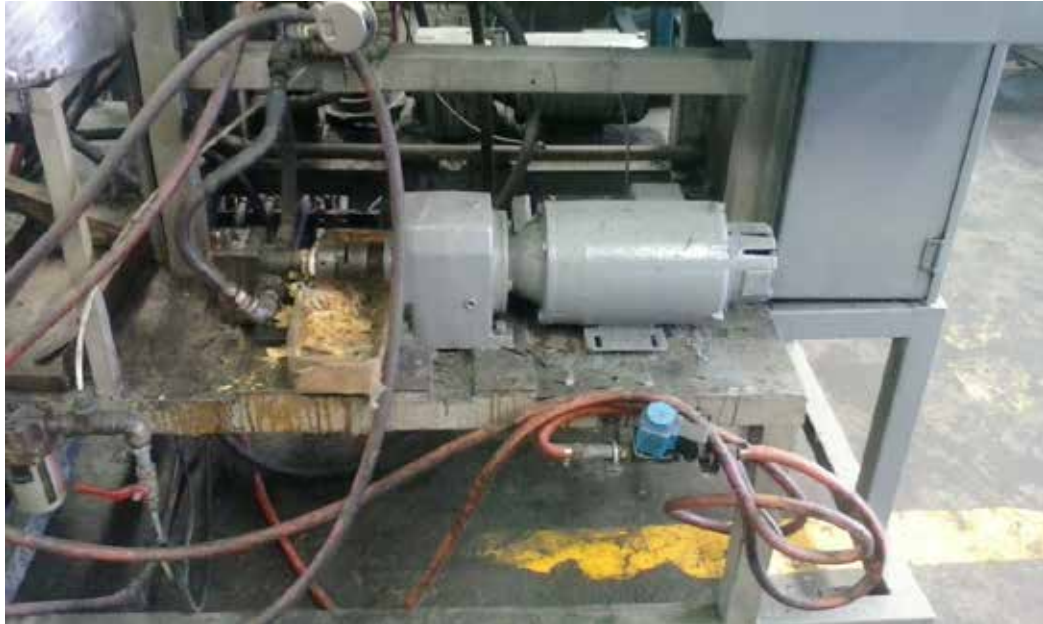
Anexo A: Figura 5. Bomba de recirculación de la línea de alimentación de Poliolo e Isocianato
