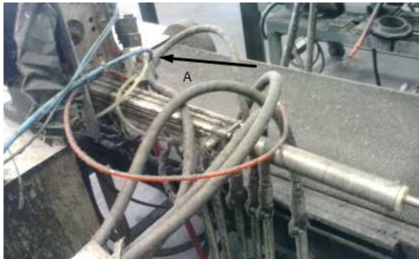
Anexo A: Figura 10. Válvula neumática 5/2 del actuador principal (A) Fuente. Cristopher Chacón (2018).
