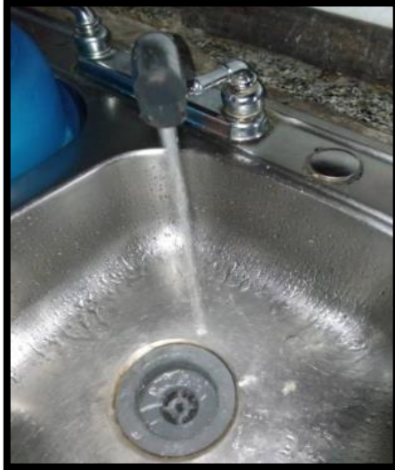
Figura 5. Curado de la tubería para Captación de la Muestra 1. Fuente: Maralys Márquez (2021)
