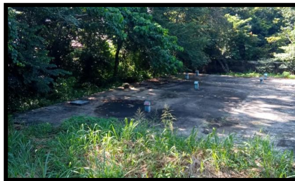
Figura 12. Tanque de distribución de agua, ubicado en la comunidad de Carialinda. Fuente: Maralys Márquez (2021)
