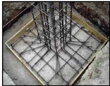
Figura 5. Zapata aislada
