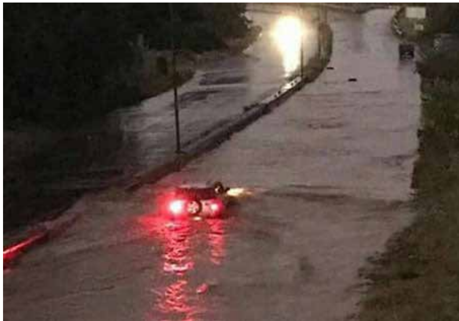
Figura 40: Autopista inundada, a unos 300 metros del puente.
