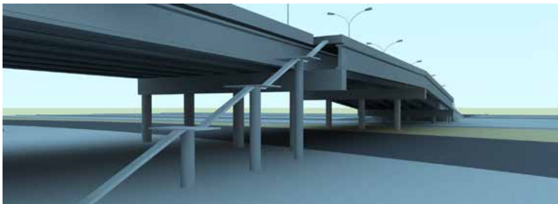
Figura 32: Vista acceso Centro – Rancho Grande peatonal al puente
