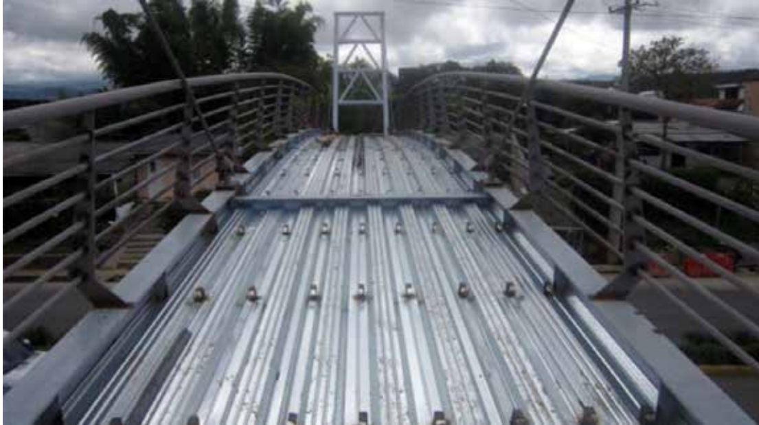
Figura 33: Disposición de losacero en rampas
