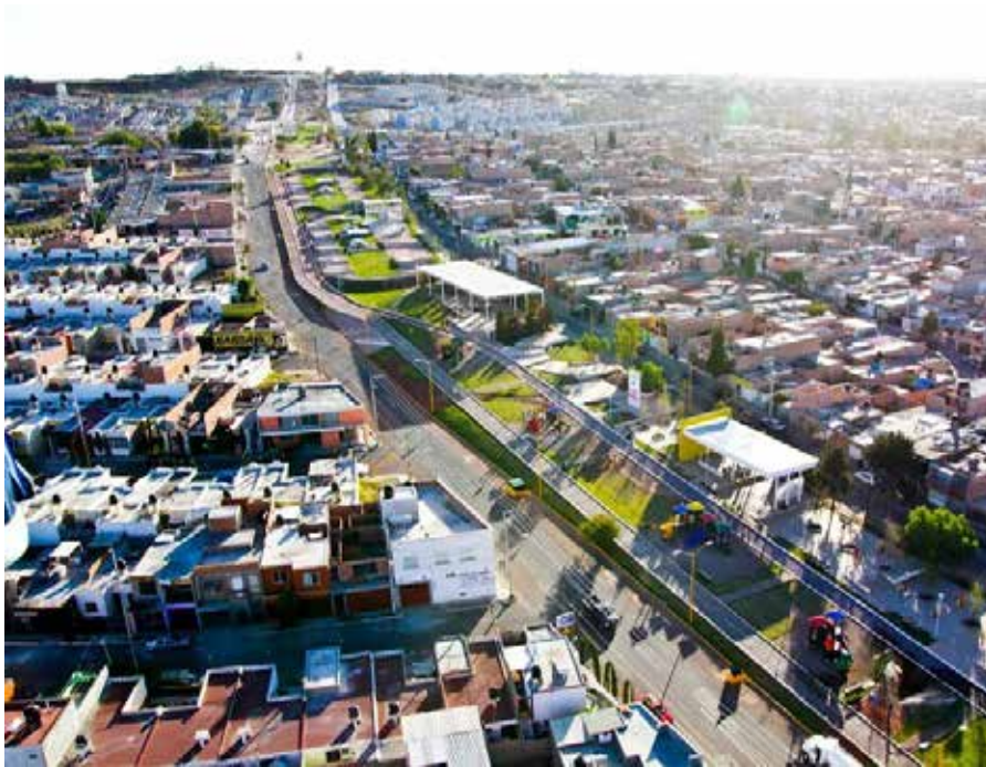
Figura 1. Vista aérea del parque ( https://www.plataformaarquitectura.cl/cl/02-340597/parque-ecologico-linea-verde-el-caso-de-reconversion-urbana-de-aguascalientes-en-mexico/5314eb0bc07a80b93f0000ea )
