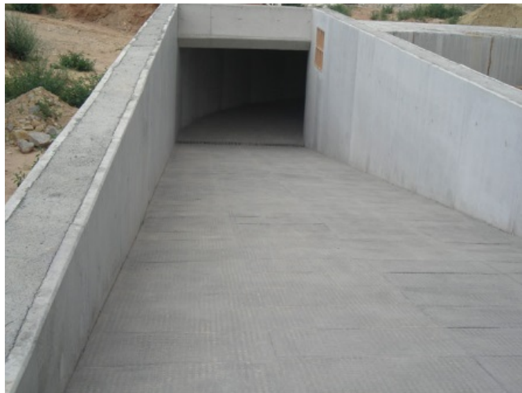
Figura 58: Sotano en concreto limpio. Fuente: http://www.previenva.es/productos/contencionsotano2.jpg (2017)
