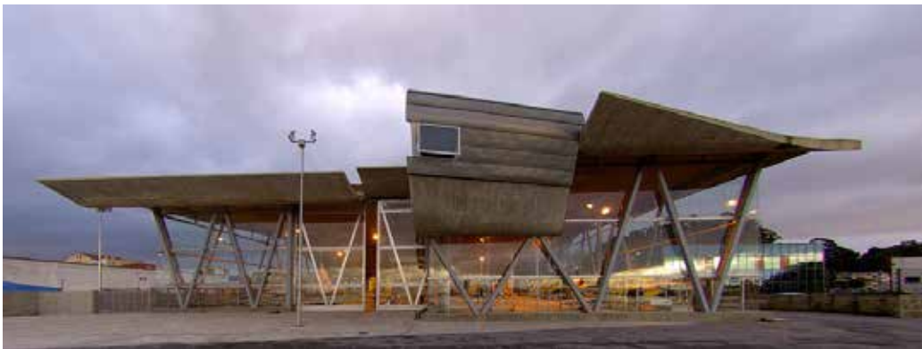
Figura 9. Centro de Tecnificación de Vela. Fuente: ( www.misturas.es/project/escuela-de-vela-vilagarcia-de-arousa ) Fotografía: Rubén Ulloa (2009)
