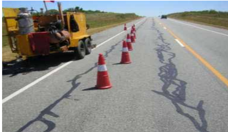
Figura 32: Sellado de fisuras y grietas
