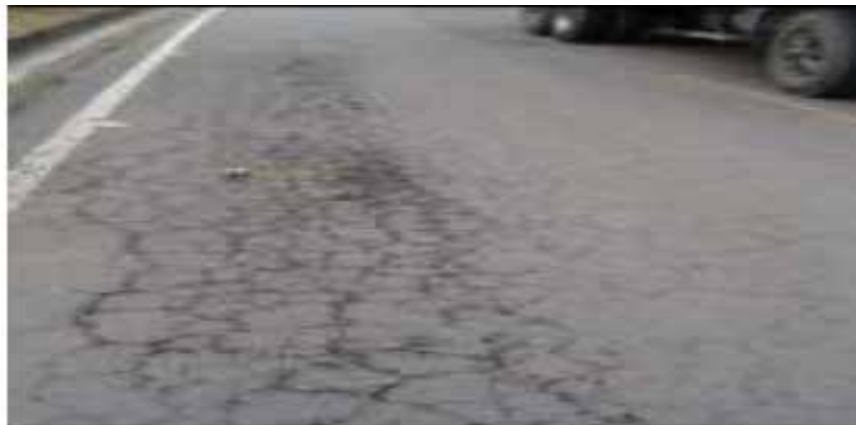
Figura 6: Falla Por Fatigamiento
