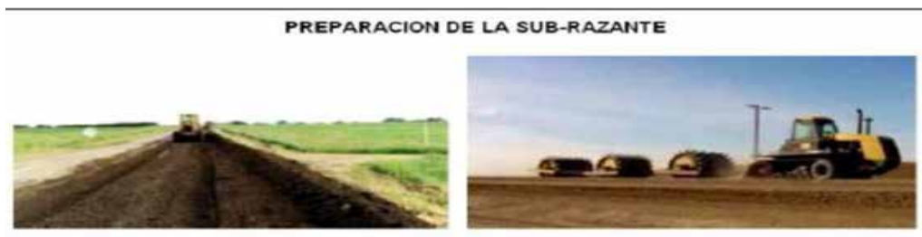
Figura 5: Preparación de la Sub-Razante
