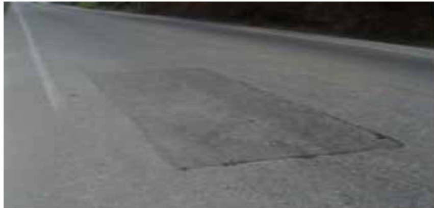
Figura 11: Parches Deteriorados
