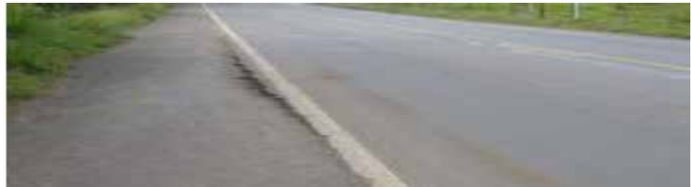
Figura 18: Descenso de la Berma
