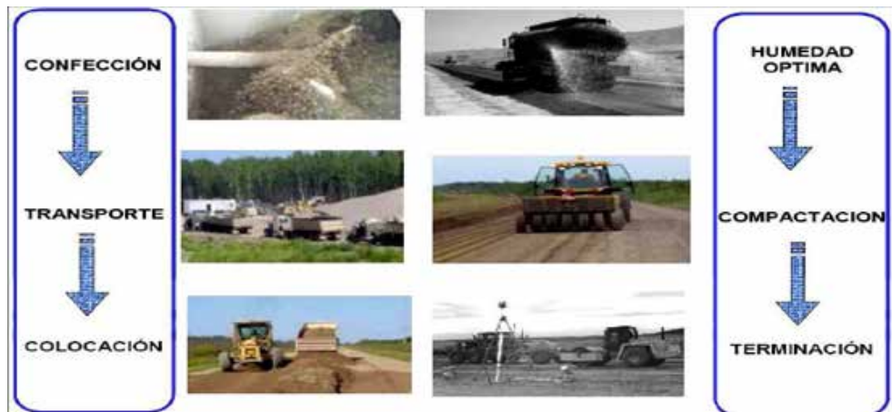
Figura 4: Etapas Constructiva de la Base
