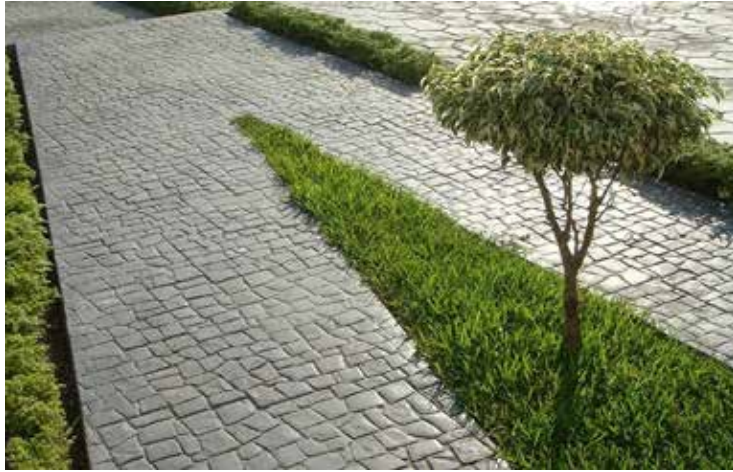
Figura 33. Acabado de Concreto estampado
